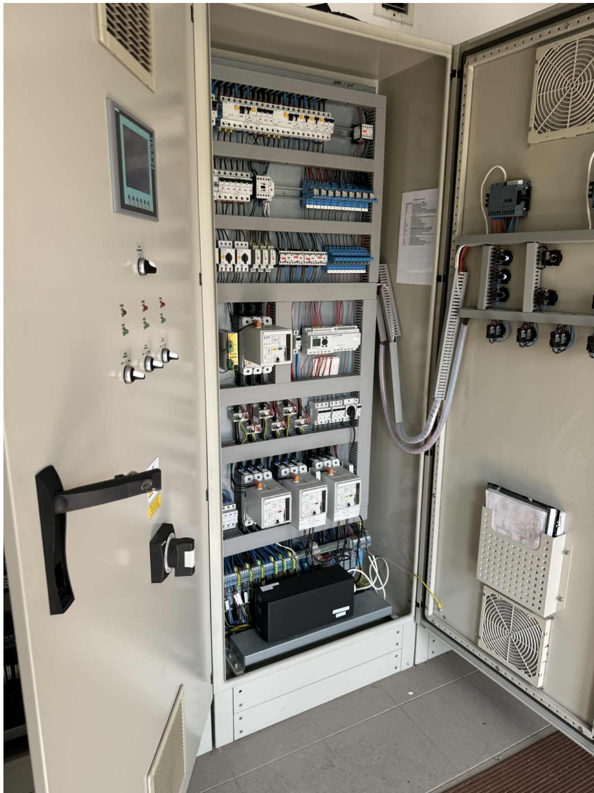
Figura 4 Miejsce wpięcia instalacji fotowoltaicznej w budynku hydroforni
